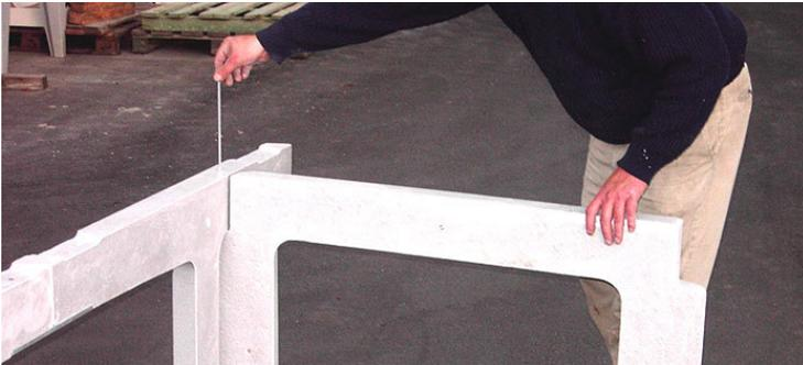
5. Platten werden auf den Unterbau gelegt und fixiert.
