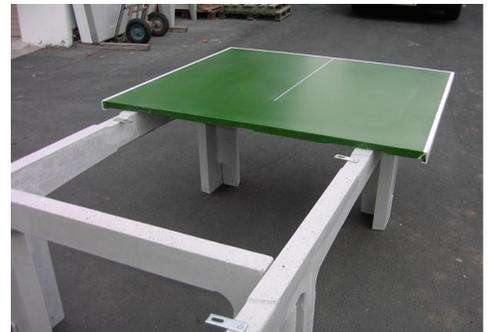
4. der Unterbau wird ausgerichtet. Bitte überprüfen Sie den rechten Winkel
