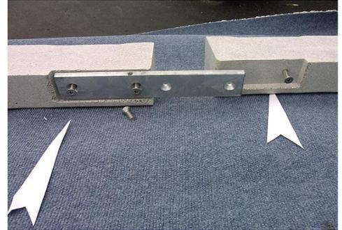
3. Das kurze und das lange Unterbauteil werden zusammengestellt und mit einem Aluminiumstab fixiert.
