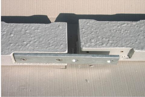
2. Verbinden der beiden Unterbauteile
