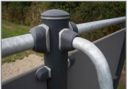
Die Verbinder sind aus druckgegossenem Aluminium hergestellt, das speziell für den Außenbereich und starke Beanspruchung legiert ist. Die Schrauben zur Befestigung der Verbinder sind aus Edelstahl und durch Zink-Unterlegscheiben geschützt.
