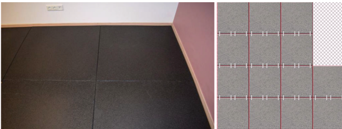
Platten zusammendrücken; Verlegung der Platten im Schachbrettmuster
