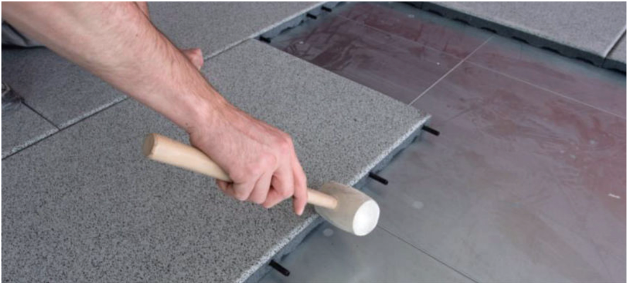
Schließen von Lücken mit einem Hammer
