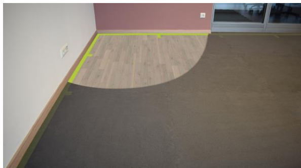
Bei 8-10mm : Verklebung nur im Randbereich oder an Kanten bei Zuschnitten
