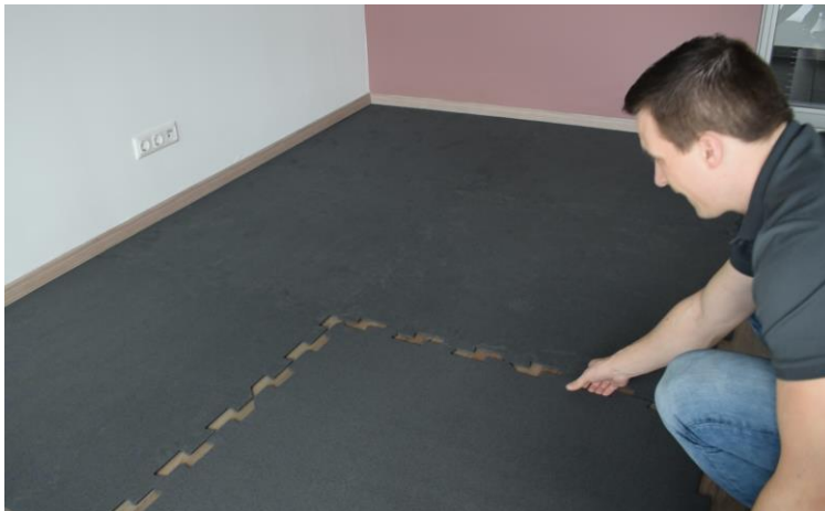
Installation der weiteren Matten
