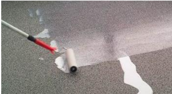
Auftragen der Versiegelung
