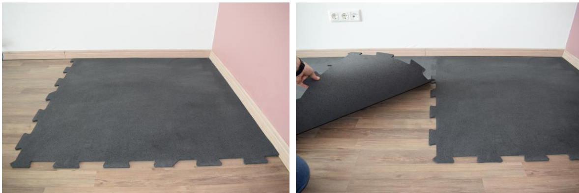
zugeschnittene Matte platzieren; entlang der Wand die nächste Matte mit den Zähnen verbinden
