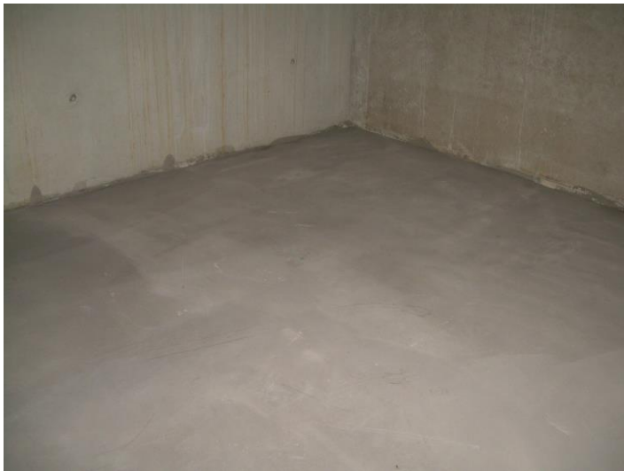
Glatter, geeigneter Untergrund aus Betonestrich
