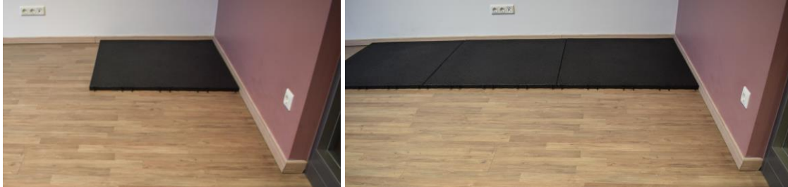
Verlegung der Platten entlang einer graden Wand mit den Steckverbindern nach vorne
