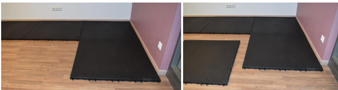
Die zweite Reihe mit den Platten genauso beginnen und fortfahren; Platte neben Platte legen
