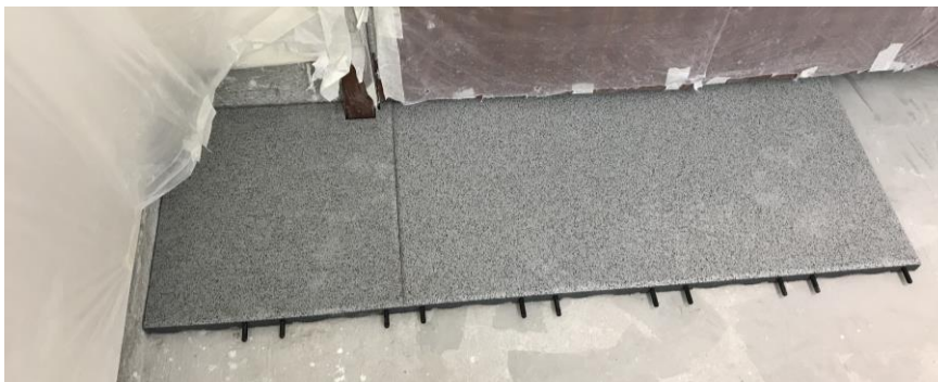
Verlegung der Platten entlang einer graden Wand mit den Steckverbindern nach vorne
