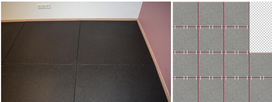
Platten zusammendrücken; Verlegung der Platten im Schachbrettmuster
