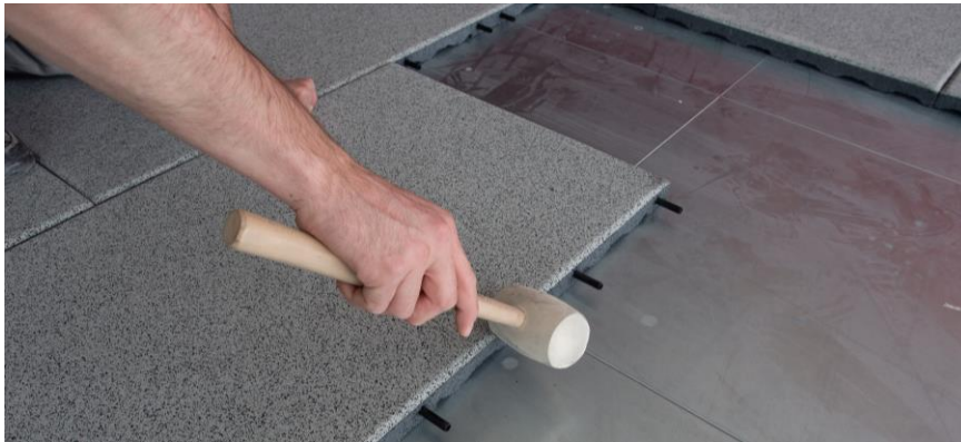
Schließen von Lücken mit einem Hammer
