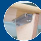
Verschraubung mit Quergewindebolzen und stabilen Verbindungswinkeln
